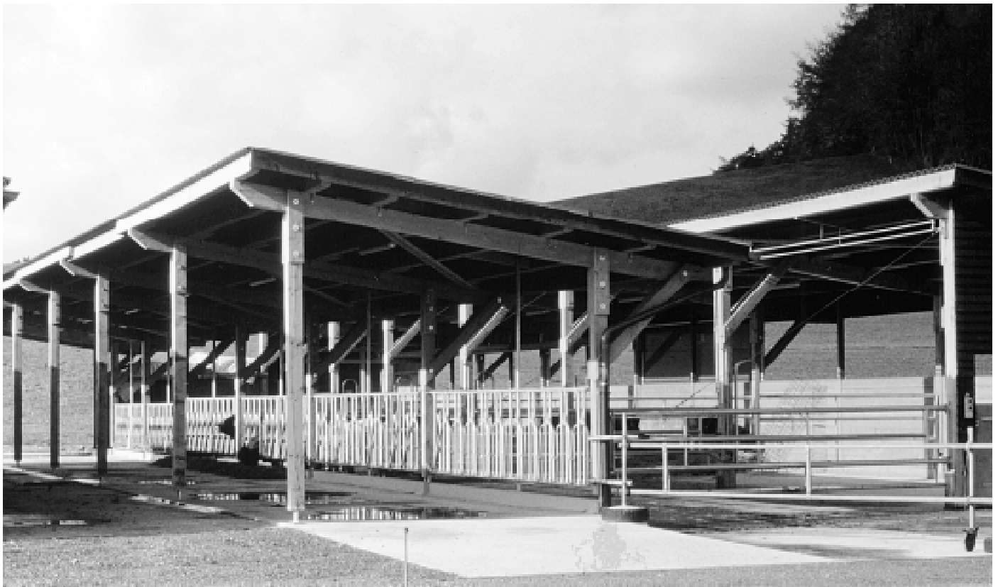
Abb. 2. Ansicht der Stallanlage von Osten. Die einfache Holzkonstruktion von Futterterrasse und Liegehütte ist sehr eigenleistungsfreundlich.
