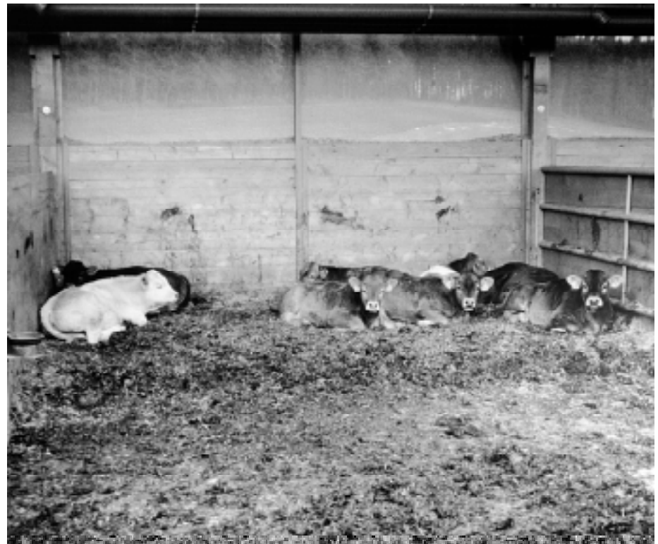
Abb. 3. Blick vom Lauffhof auf die Liegefläche. Die geschlossenen Buchtenwände und das Windschutznetz an der Rückwand reduzieren Zugerscheinungen im Liegebereich. Am oberen Bildrand ist die Rohrleitung der Einstreuvorrichtung zu sehen.
