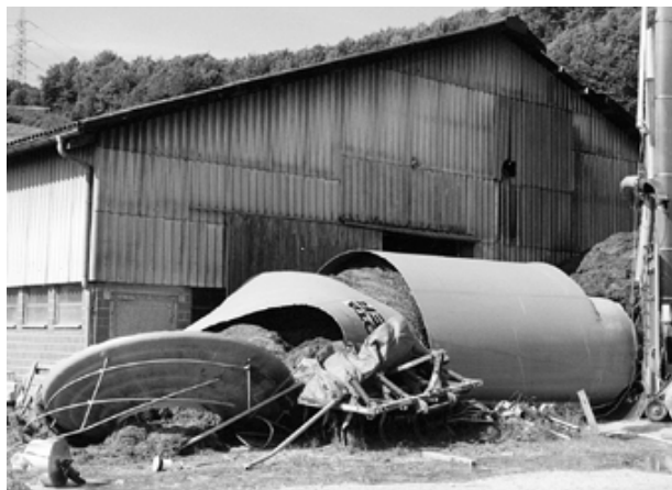
Abb. 1. Umsturz eines geschleuderten Silos, gefüllt mit nassem Grashäcksel.
