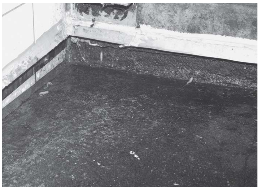
Abb. 3. Winkelbleche der Wand entlang verhindern das Eindringen der Larven in den Melkstand.
