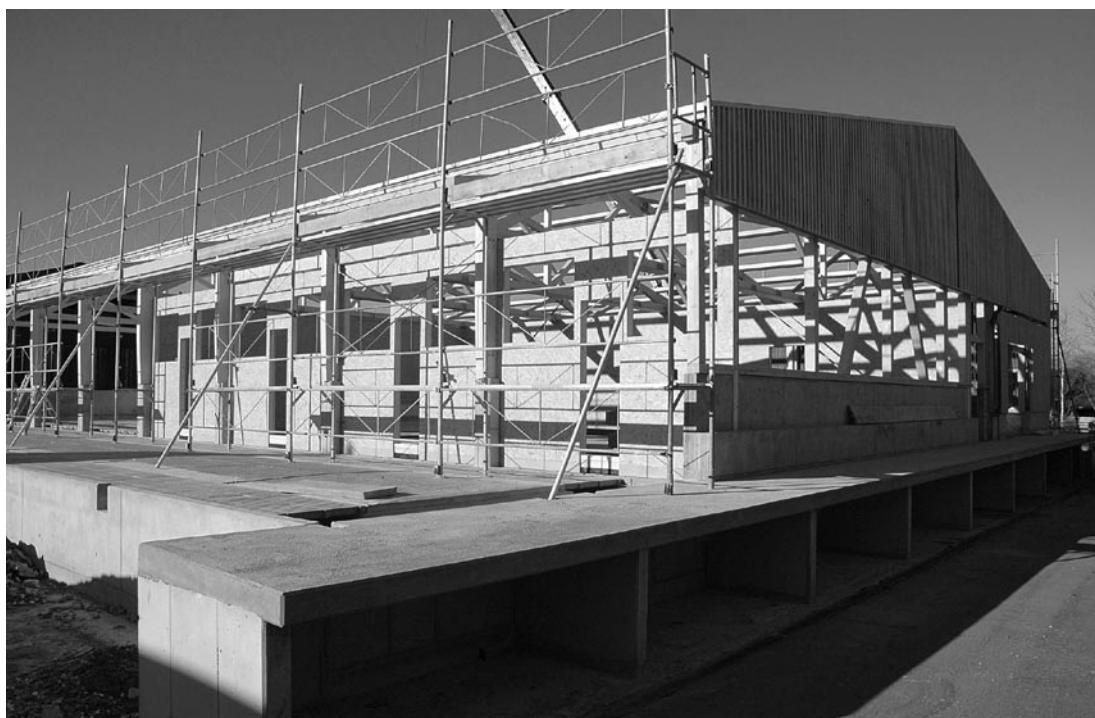
Abb. 3. Im Kanton Luzern wird ein Drittel aller Schweineställe der Schweiz gebaut (Foto: Agroscope ART).
