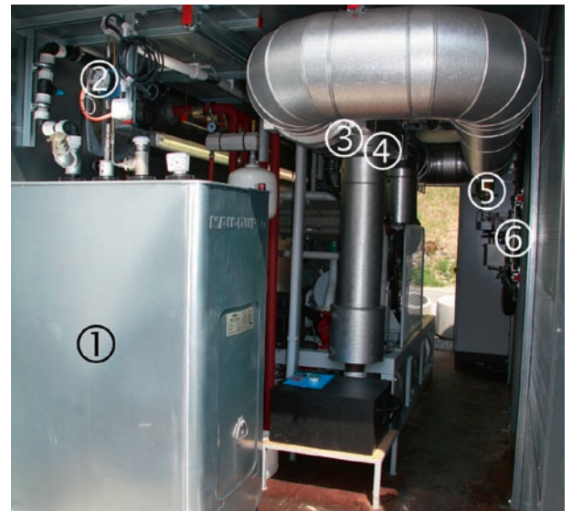
Abb. 2. Blick auf Ta-gestank 1; Zusatzför-derpumpe für Pflan-zenöl 2; Partikelfilter 3; SCR-Katalysator 4 und Harnstoffinjektion vor Mischstrecke 5.
