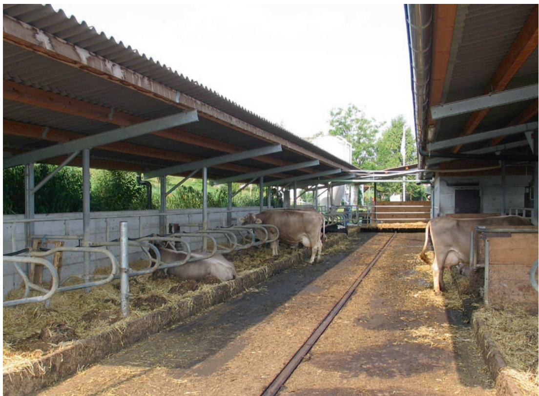
Abb. 5. Der Mehrgebäudelaufstall erreicht dank seiner einfachen Konstruktionsweise in allen relevanten Umweltwirkungen den niedrigsten Wert.
