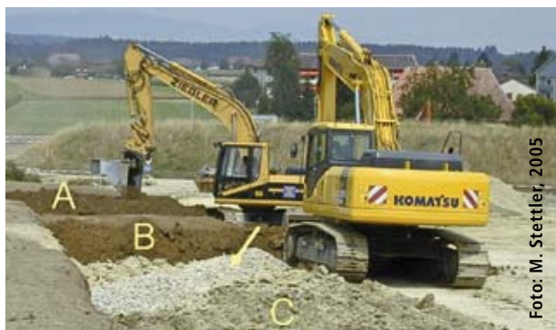
Abb. 1 | Streifenweise Rekultivierung der Ackerböden auf der Tunnelausbruch-Deponie Schacht bei Wanzwil: A=Oberboden; B=Unterboden; C=Rohplanie mit Kiesstreifen (Pfeil) als Drainage.
