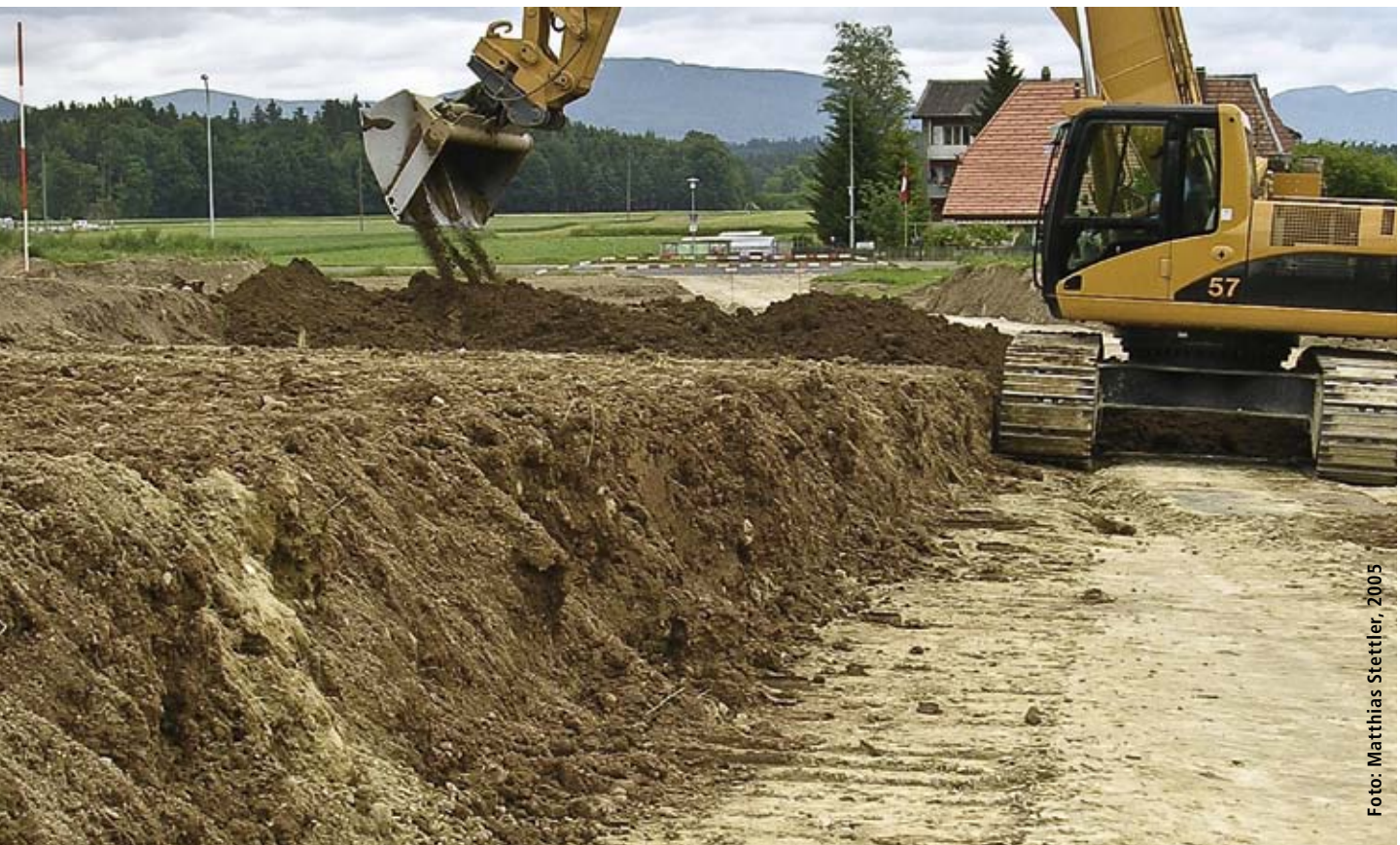
Schüttung des Oberbodens auf den vorbereiteten Unterboden.
