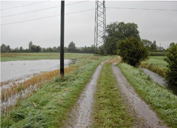
Abb. 2 | Der Fahrweg bildet eine topographische Barriere, die verhindert, dass Oberflächenabfluss vom Feld links in den Bach auf der rechten Seite der Strasse fließen kann. (Foto: Martin Frey, Eawag)
