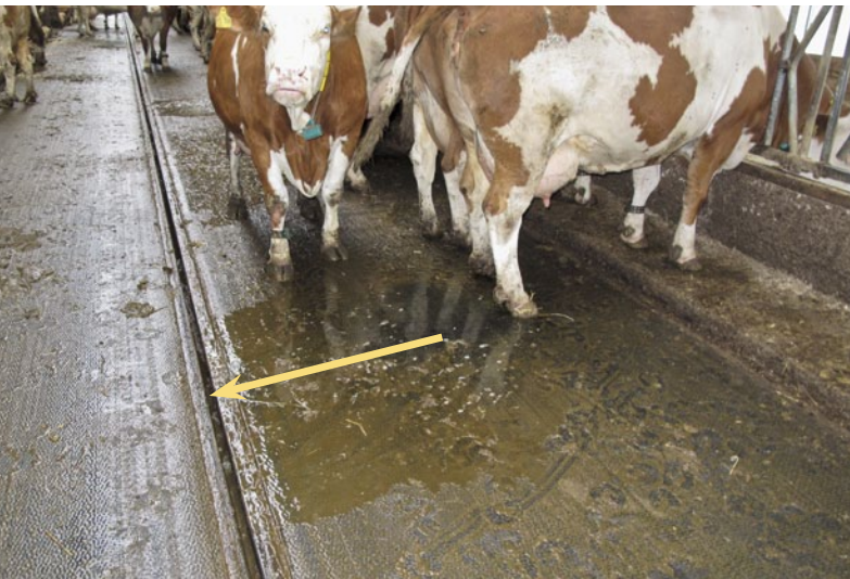
Abb. 1 | Zur Minderung der Ammoniakemissionen ist ein rasches Ableiten des Harns erforderlich. (Foto: ART)
