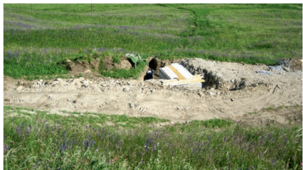
Abb. 6 | Bau neuer Bewässerungsanlagen im Bereich schützenswerter Salbei-Glatthaferwiesen (Sent 2010). (Foto: Roman Graf)
