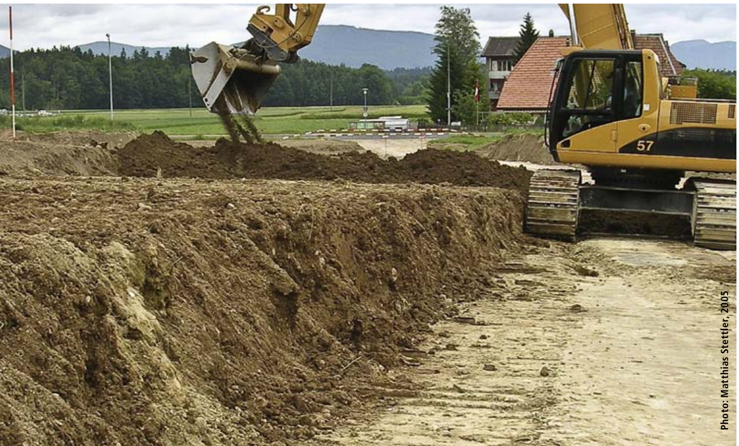
Reconstitution du sol: déversement de la terre superficielle sur le sous-sol préalablement préparé.
