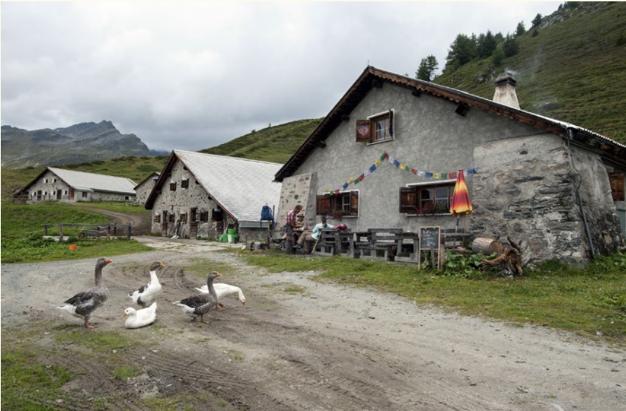
Figure 3 | Alp Sura, commune de Guarda GR. Les bâtiments ont été construits en 1921, conformément aux plans de l'Office des améliorations foncières du canton des Grisons. Le canton des Grisons faisait partie des régions qui, grâce à Oscar Good, alors directeur de l'Office cantonal des améliorations foncières, remplaçait les bâtiments d'alpage traditionnels de la façon la plus systématique possible par des bâtiments rénovés et homogènes. (Photo: Gabriela Brändle, Agroscope)
