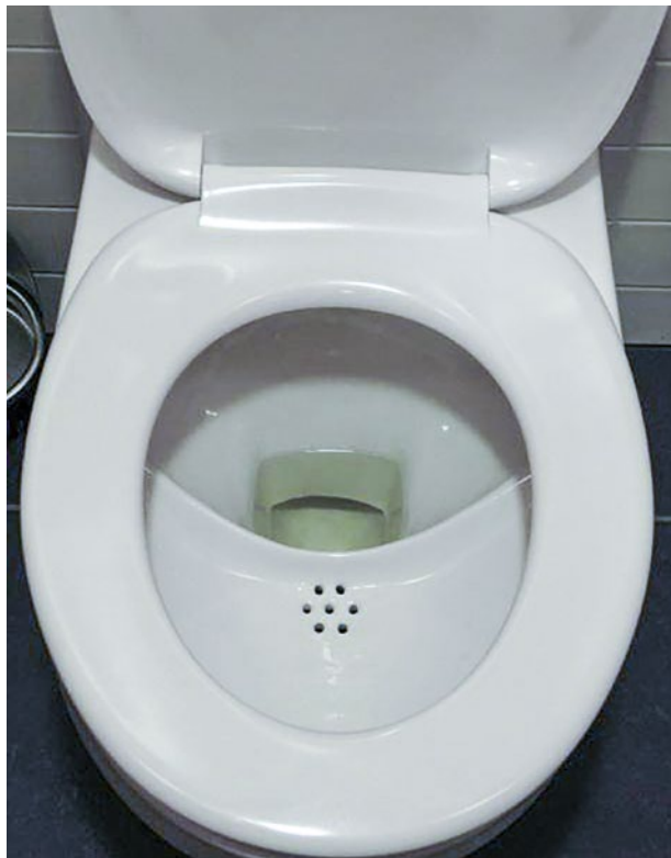
Figure 2 | Les «toilettes séparatrices» simplifient la récupération des éléments nutritifs, tels que le phosphore des excréments humains. (Photo: Kai Udert Eawag)
